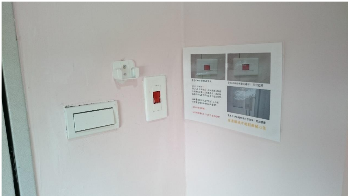
電燈開關旁有緊急按鈕供緊急時通知樓下櫃台人員。
